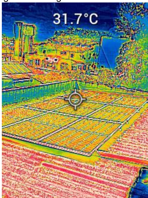
Figura 8 - Imagem térmica módulo 3.
